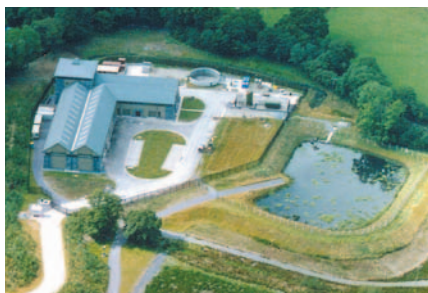
Пример труднодоступной насосной станции
