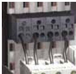
Шины Powerclip с ответвительными клеммами на 6/10 мм 2
