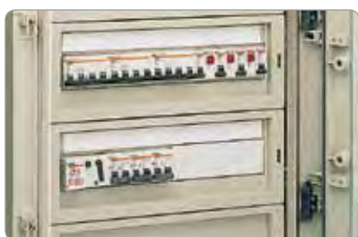
Фрагмент системы маркировки цепей
