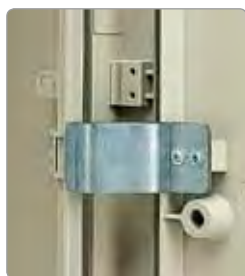
Система предотвращения взлома двери посредством рычага
