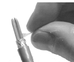
Удаляется защитная пленка жил кабеля.
